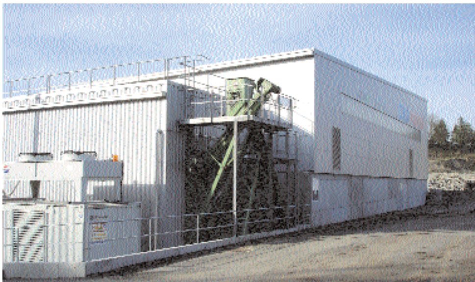
Fig. 1. Impianto di Ottenbach: vista d'insieme.
