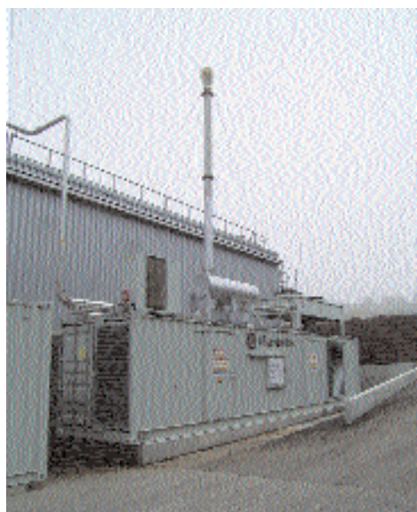
Fig. 3. Container cogeneratori.
