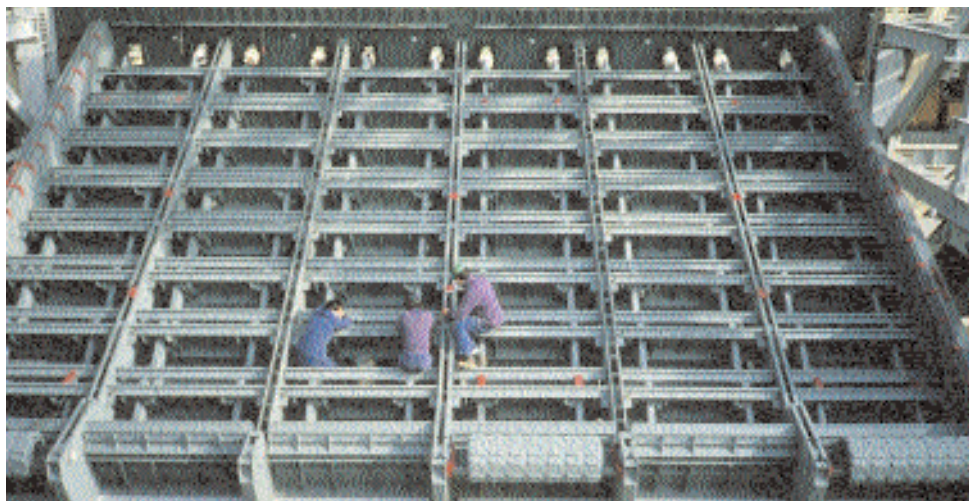
Fig. 5. TU di Brescia: combustore a griglia in fase di montaggio.
