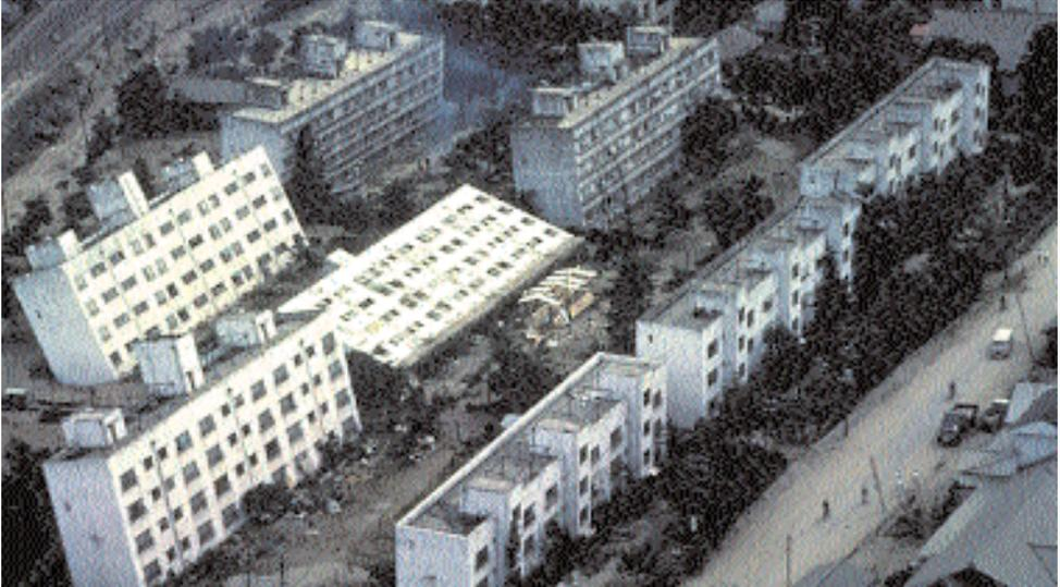
Fig. 3.7. Danni indotti da fenomeni di liquefazione durante il terremoto di Niigata 1964.
